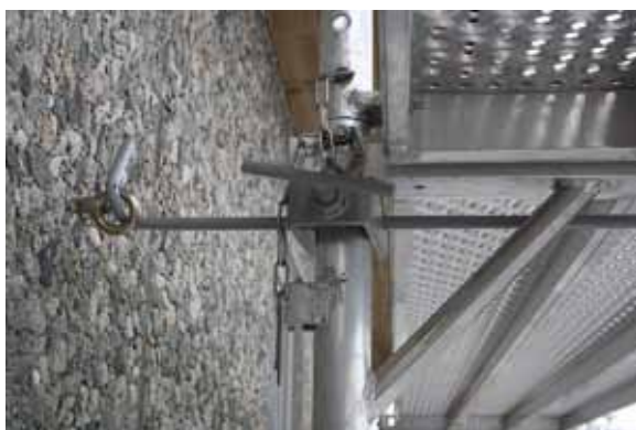
Właściwie zamontowana kotwa do wewnętrznego słupka
